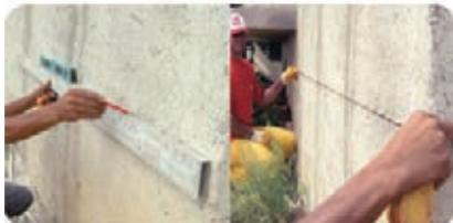
Монтажная поверхность должна быть оштукатуренной и ровной. Это проверяется с помощью отвеса, веревки и уровня.
