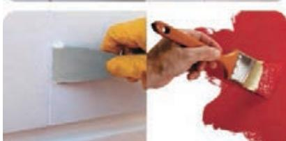
Заполнить канал с помощью эластичной шпатлевки CMC IZOLASYON. После высыхания шпатлевки стыки нужно отшлифовать (за исключением покрытий с эффектом камня, мрамора и дерева).
