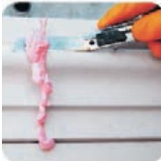
Макетным ножом срезать излишки высохшей пены и в месте соединения сформировать канал глубиной максимум 2 мм. Заполнить канал с помощью эластичной шпатлевки CMC IZOLASYON. После высыхания шпатлевки стыки нужно отшлифовать.
