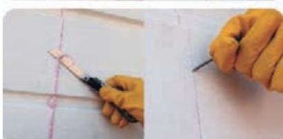
Макетным ножом срезать излишки высохшей пены и в месте соединения сформировать канал глубиной максимум 2 мм.
