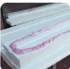
Обратную сторону элемента MAGRA DECOR нужно обработать с помощью гребенки kleевым составом CERESIT (CT 84) или другим аналогичным составом.
