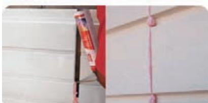
Для склеивания деталей между собой рекомендуется к использованию полиуретановый клей CERESIT (CT 84). После обработки стыков полиуретановой пеной детали нужно плотно прижать друг к другу. Оставить до полного высыхания клея.
