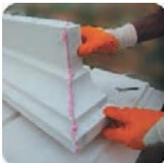
После обработки стыков полиуретановой пеной детали нужно плотно прижать друг к другу. Оставить до полного высыхания клея. При необходимости можно использовать механическое крепление с помощью гвоздей.
