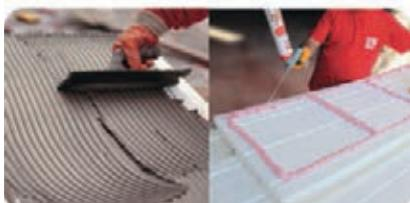
Обработанную сторону изосайдинга MAGRA DECOR нужно обработать с помощью гребенки клеевым составом на цементной основе CERESIT (CT 85) или другим аналогичным составом. В зависимости от поверхности стены можно использовать полиуретановый клей CERESIT (CT 84), он наносится на поверхность изосайдинга специальным пистолетом. Монтаж осуществляется снизу вверх, при необходимости изосайдинг можно дополнительно зафиксировать снизу гвоздем (это нужно делать пока клей не высох)
