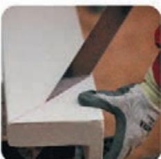
Декоративный элемент режется под углом в 45 градусов с помощью ручной пилы или специального оборудования.
